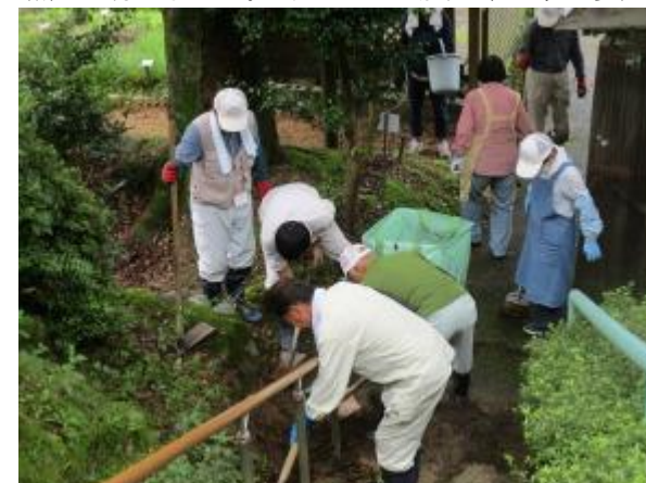
枯れ葉や土で流れが悪くなっていた側溝も、掃除を行い水の流れが良くなりました。
